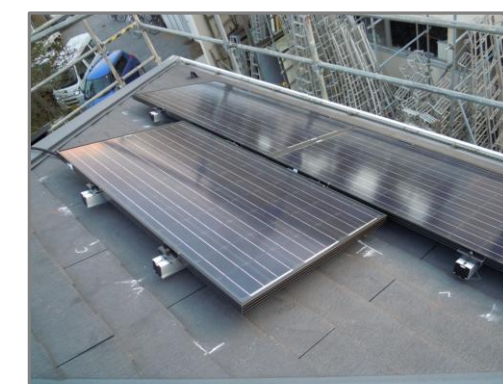
太陽光パネル設置状況
