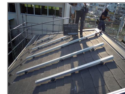
架台設置状況
