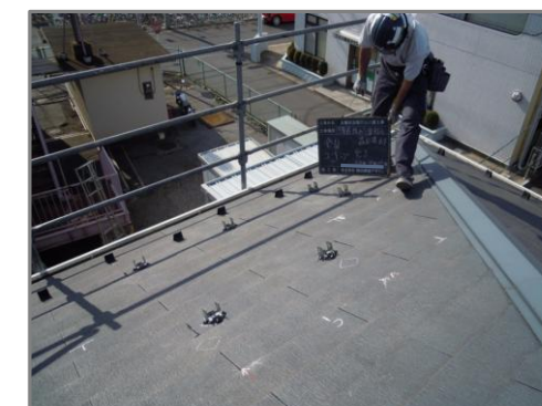
スレート支持金具設置状況
