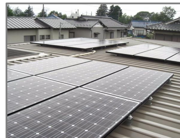
太陽光パネル設置状況
