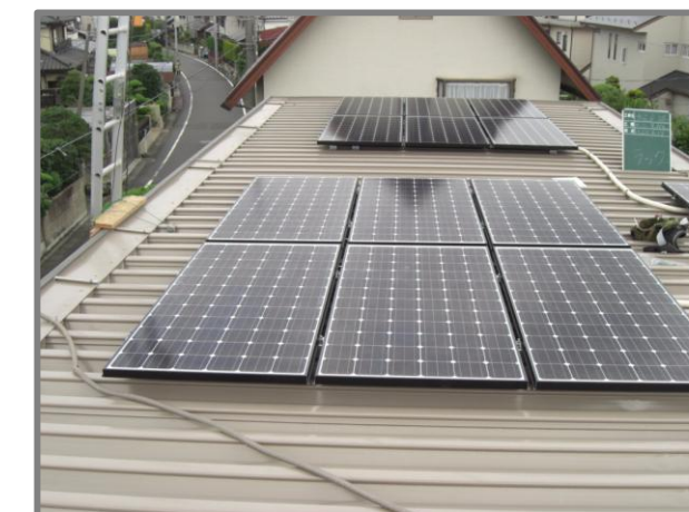
太陽光パネル設置状況
