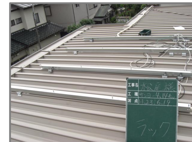
架台設置状況
