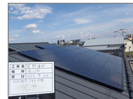
太陽光パネル設置状況
