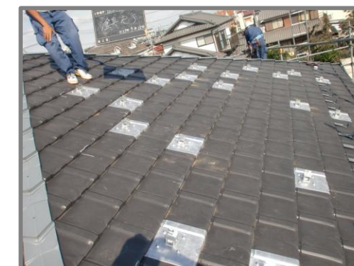
支持瓦金具設置状況
