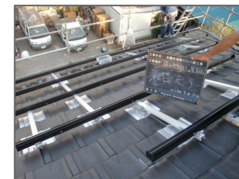
架台設置状況
