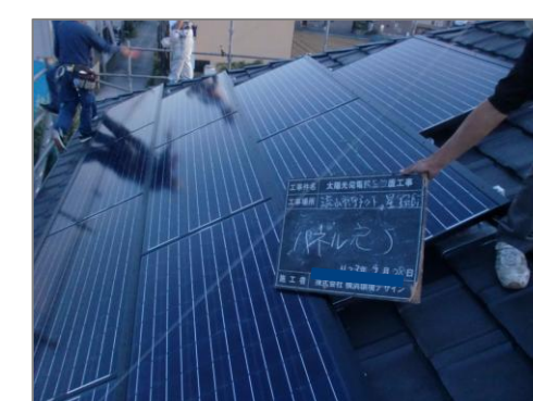
太陽光パネル設置状況
