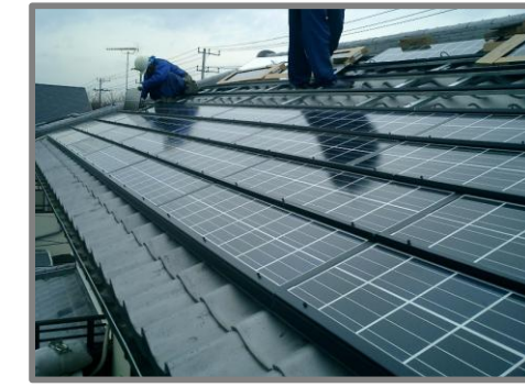
太陽光パネル設置状況
