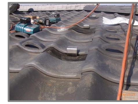
瓦支持金具設置状況
