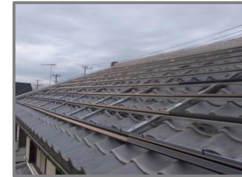
架台設置状況
