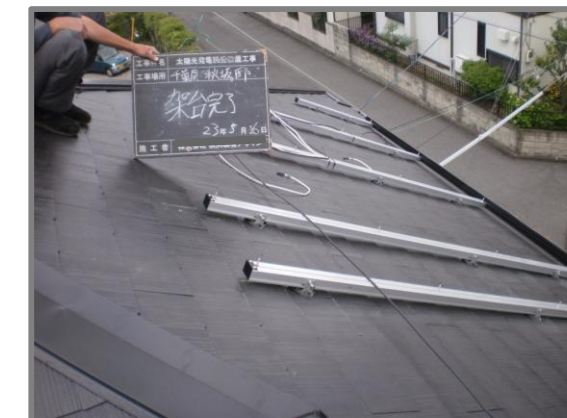
架台設置状況
