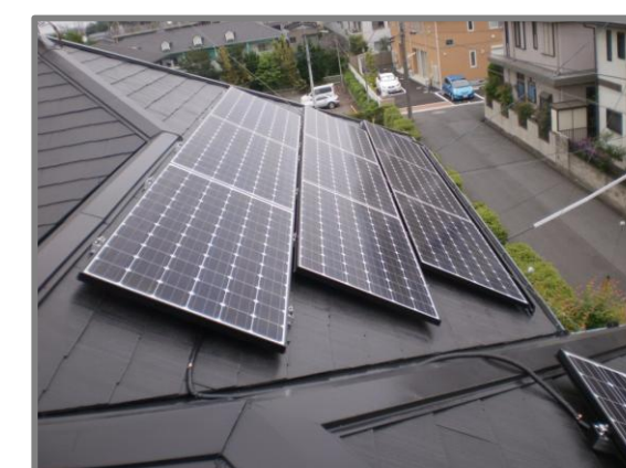
太陽光パネル設置状況
