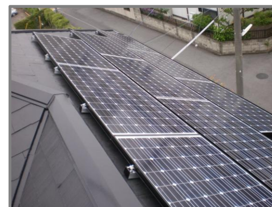
太陽光パネル設置状況
