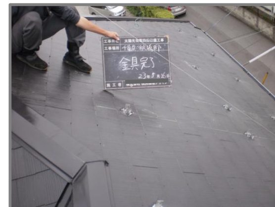
スレート金具設置状況
